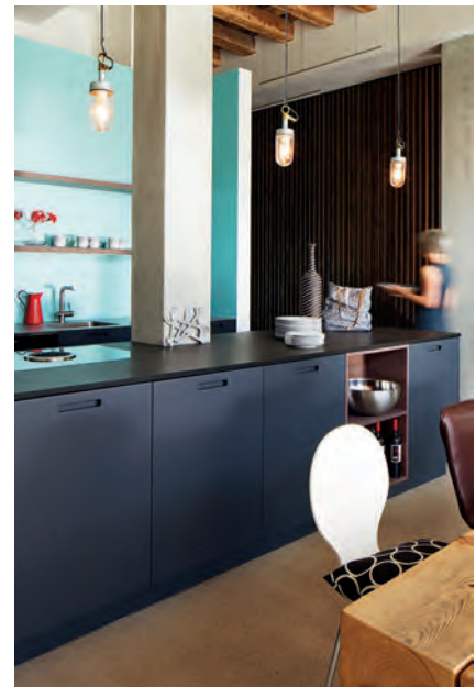
Unten: Die Stahlstütze musste aus feuerpolizeilichen Gründen mit Gips verkleidet werden. Sie wurde in die neue Kochinsel von Varenna integriert. Schiffsleuchten aus England.
